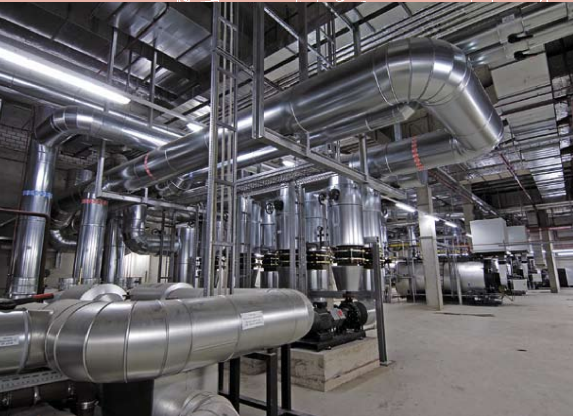
■ Im übersichtlich aufgebauten Kesselhaus stellen drei Kessel mit Elco-Brennern die Wärmeversorgung sicher.
