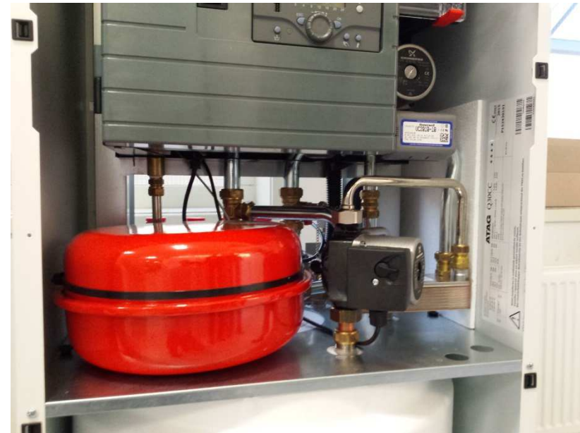
12 Liter MAG für Heizung integriert
